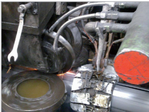
开始焊接前检测管道边缘温度
